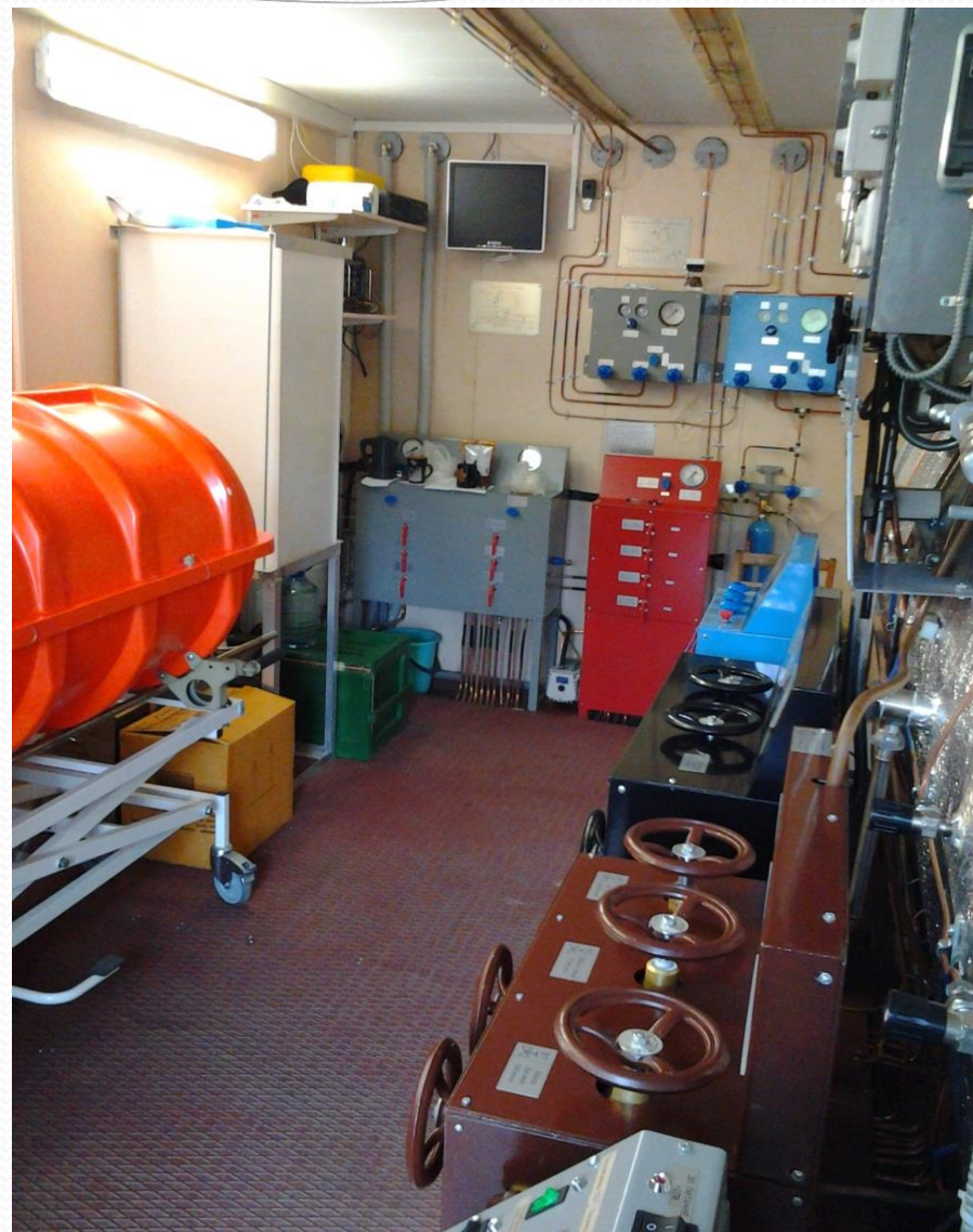
Вид внутри (от входа)
